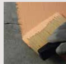
Aplicación de pintura elastomérica protectora antifisuraciones.
