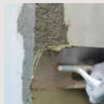
Aplicación de mortero cementoso para el acabado del hormigón.
