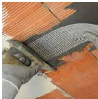
Geolite Magma Xenon combinado con las fibras cortas de elevadas prestaciones Steel Fiber, certificadas para uso estructural, forman el sistema certificado, Geolite FRC para el refuerzo de forjados y elementos de hormigón armado.
