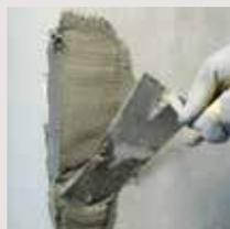
Aplicación de mortero polímero-modificado de retracción controlada, fibrorreforzado para el saneamiento del hormigón.
