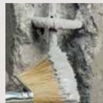
Aplicación de mortero cementoso anticorrosivo bicomponente para la protección de la armadura.
