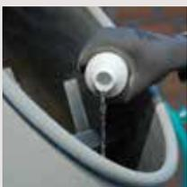
Preparación del mortero polímero-modificado con posible aditivación acelerante o retardante.
