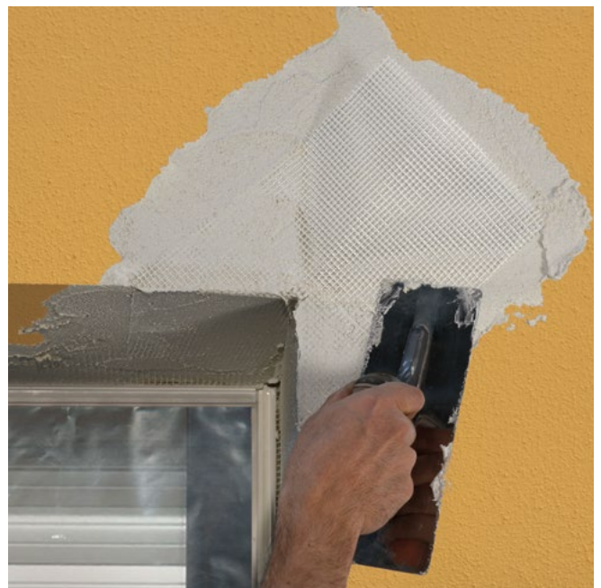
Applicazione fazzoletto di rete di rinforzo
