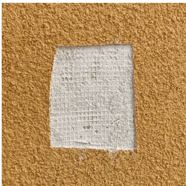
Rimozione localizzata del ciclo di finitura e 2ª mano di rasatura
