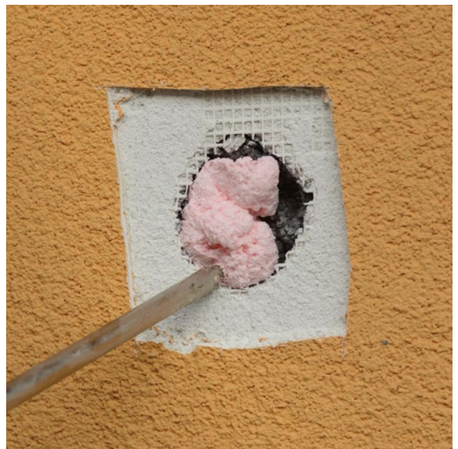
Applicazione idonea schiuma poliuretana a riempimento
