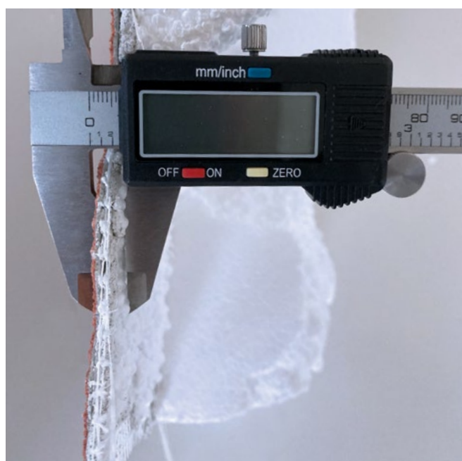
Verifica qualità sistema ETICS esistente
