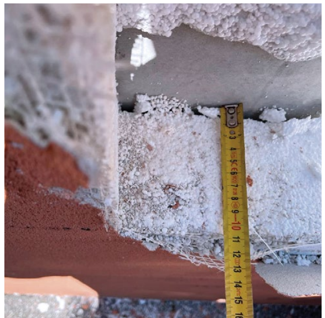
Verifica stato di fatto sistema ETICS esistente
