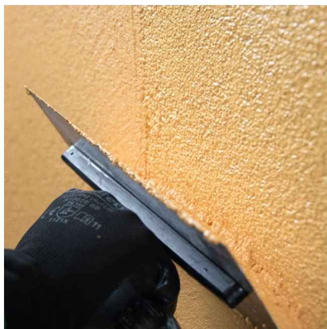
Applicazione del ciclo di finitura (fondo e intonachino a spessore)
