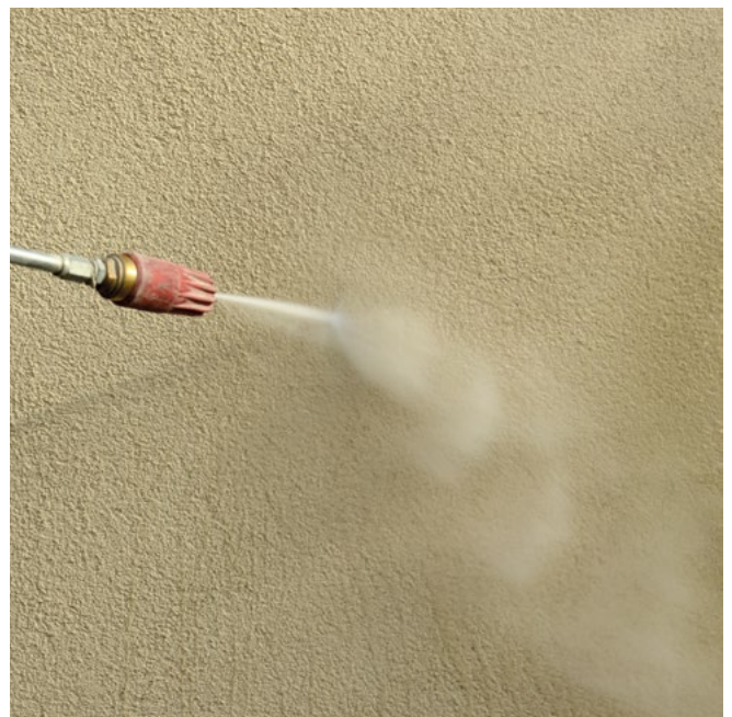
Idrolavaggio della superficie
