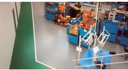
3.3_ Dik meerlaags systeem Afwerking met schorseffect d. \approx 2,5-3 mm
