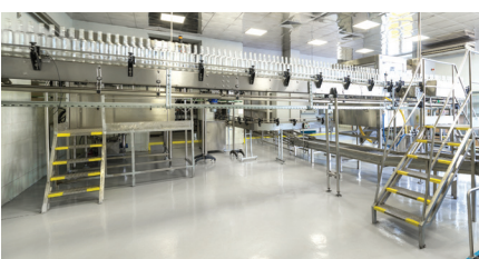
5.2_ Harsmortelsysteem Antislip afwerking d. > 5 mm
