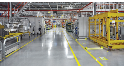
5.1_ Harsmortelsysteem Afwerking met schorseffect d. > 5 mm
