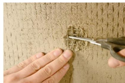
Installazione del **Diatono Geosteel** e **Iniettore&Connettore Geosteel**.
