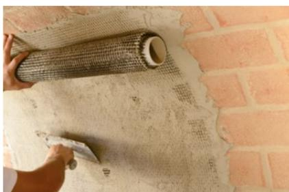
Taglio della rete biassiale in fibra di basalto **Geosteel Grid** a livello del foro di iniezione.
