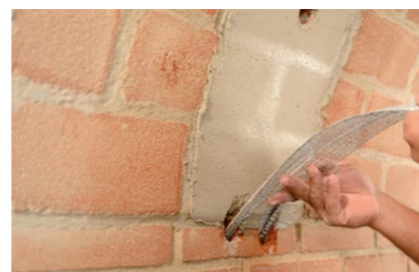
Installazione del tessuto in fibra d'acciaio Geosteel .
