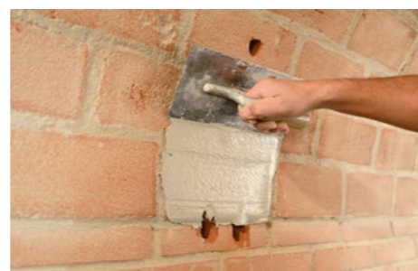
Applicazione prima mano di Geocalce F Antisismico .
