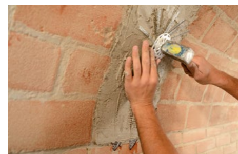
Installazione del Diatono Geosteel .
