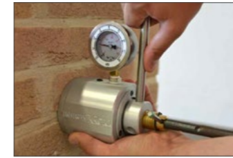
UTILIZZO DELL'ESTRATTORE CERTIFICATO DI KERAKOLL SPA PER LE PROVE PULL-OUT IN CANTIERE PER LA VERIFICA DELLA TENUTA DELLE BARRE ESISTENTI
