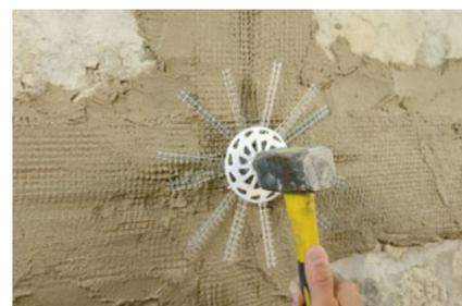
Applicazione seconda mano di **Geocalce F Antisismico**.
