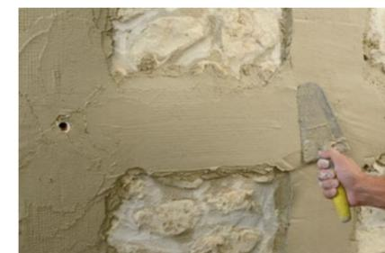
Inghisaggio del diatono con iniezione a bassa pressione di **Geocalce FL Antisismico** e chiusura del foro con apposito tappo.
