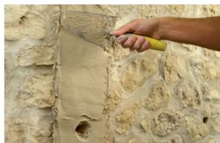
Installazione delle fasce di tessuto in fibra d'acciaio **Geosteel G**.
