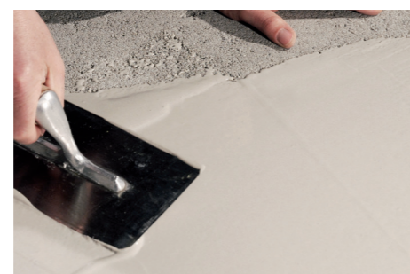
Applicazione prima mano gel-membrana impermeabile Nanoflex No Limits .
