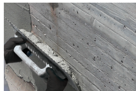
Applicazione di rasante impermeabile minerale Aquastop Scuba .
