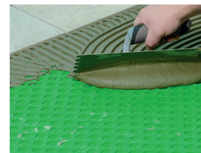
Applicazione del Gel-Adesivo strutturale flessibile multiuso H40 No Limits .
