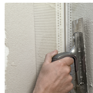
Applicazione malta tixotropica, fibrorinforzata Metric R2 Fix .
