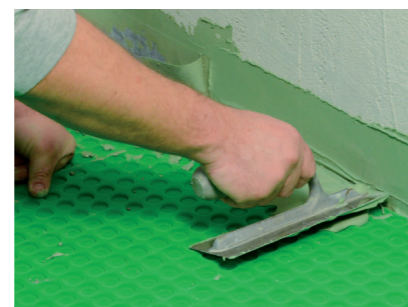
Applicazione sigillante organico monocomponente Aquastop Fix .
