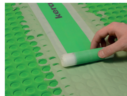
Posa del nastro impermeabile elastico in NBR Aquastop 120 .
