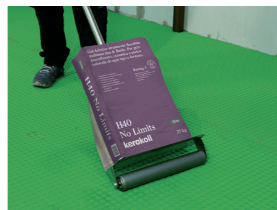
Posa della membrana impermeabile antifrattura Aquastop Green .
