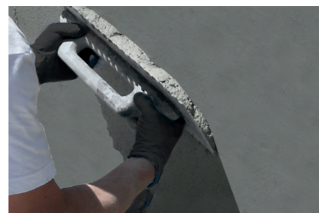
Applicazione di una seconda mano di rasante impermeabile minerale Aquastop Scuba .
