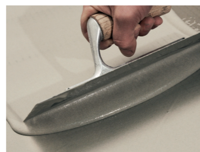
Applicazione seconda mano gel-membrana impermeabile Nanoflex No Limits .
