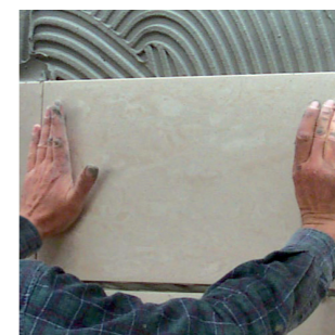
Applicazione del Gel-Adesivo strutturale ultra flessibile multiuso H40 Tech .
