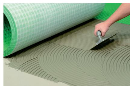
Applicazione della membrana impermeabile antifrattura **Aquastop Green**.
