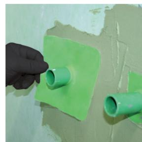
Applicazione del Gel-Adesivo strutturale **H40 Revolution**.
