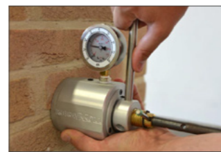
ΕΚΤΕΛΕΣΗ PULL OUT TEST ΣΤΟ ΕΡΓΟΤΑΞΙΟ ΜΕΣΩ ΠΙΣΤΟΠΟΙΗΜΕΝΗΣ ΔΟΚΙΜΗΣ ΕΞΟΛΚΕΥΣΗΣ. ΕΛΕΓΧΟΣ ΤΗΣ ΑΝΤΟΧΗΣ ΤΗΣ ΑΓΚΥΡΩΣΗΣ
