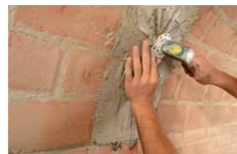
Instalação do conector realizado com tecido em fibra de aço GEOSTEEL.
