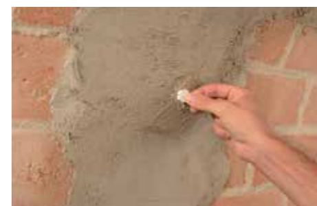
Fixação mecânica dos conectores com GEOCALCE FL ANTISISMICO e fecho do furo de injeção com a tampa de fecho própria.
