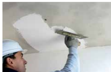
2 Aplicação da primeira demão de GEOCALCE MULTIUSO.
