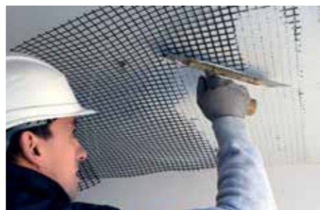
3 Instalação da rede GEO GRID 120.
