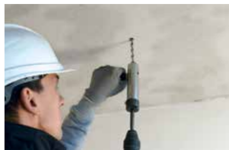
1 Instalação dos varões STEEL DRYFIX.
