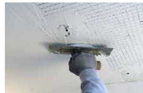
5 Aplicação da segunda demão de GEOCALCE MULTIUSO.
