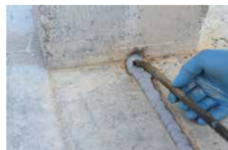
4 Inserção dos varões metálicos de ligação.
