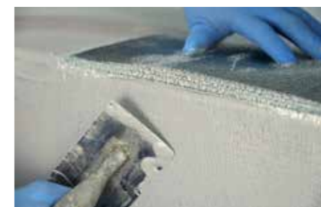
Instalação da banda em espessura milimétrica.
