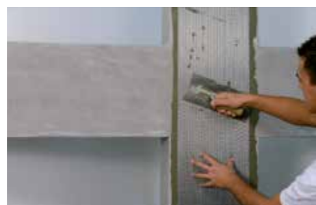
Aplicação da banda vertical de tecido em fibra de aço GEOSTEEL.
