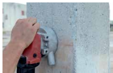
2 Preparação das superfícies de suporte.
