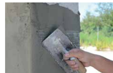
6 Instalação do tecido em fibra de aço GEOSTEEL e aplicação da segunda demão de GEOLITE.
