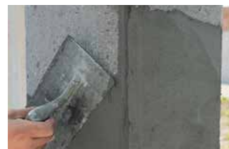
5 Aplicação da primeira demão de GEOLITE.
