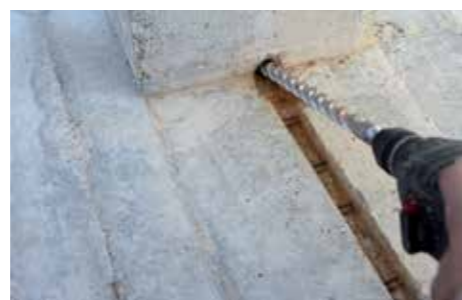
2 Execução dos furos no pilar.
