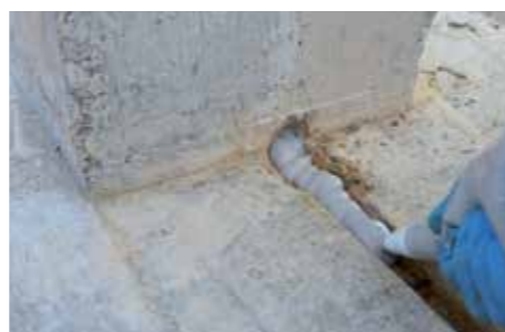
3 Enchimento dos negativos com GEOLITE GEL.
