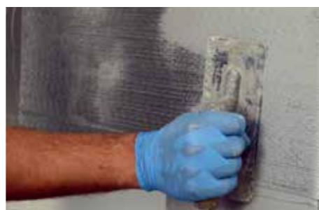
Aplicação da banda horizontal de tecido em fibra de aço GEOSTEEL.
