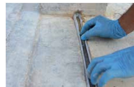
5 Fixação mecânica dos varões metálicos de ligação.
