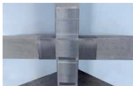
Verificação da preparação correcta das bandas de reforço.
