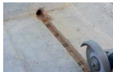
1 Abertura de negativo na laje.
