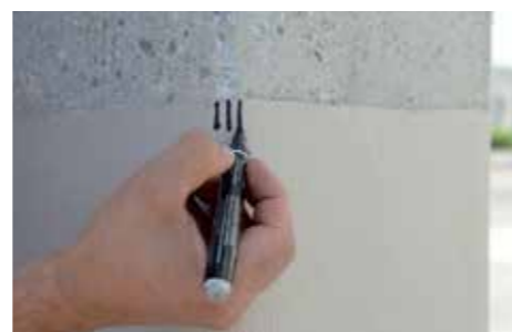
3 Indicação das zonas de tecido onde se devem efectuar as dobras.
