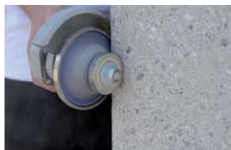
1 Arredondamento das arestas do pilar
