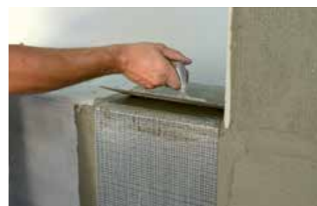
Aplicação da banda de tecido em fibra de aço GEOSTEEL para o envolvimento da viga.
