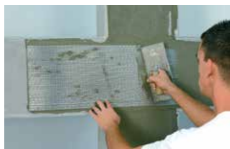
Aplicação da banda horizontal de tecido em fibra de aço GEOSTEEL.
