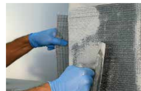
Aplicação da banda de tecido em fibra de aço GEOSTEEL para o envolvimento do pilar.
