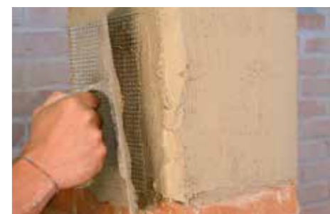
6 Instalación del tejido de fibra de acero GEOSTEEL y aplicación de la segunda mano de GEOCALCE F ANTISISMICO.
