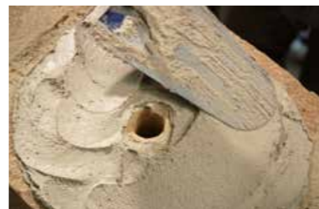
4 Realización y preparación del agujero previsto para la instalación del conector a chicote.
