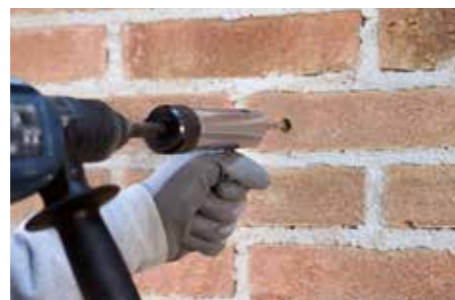
Instalación de STEEL DRYFIX.
