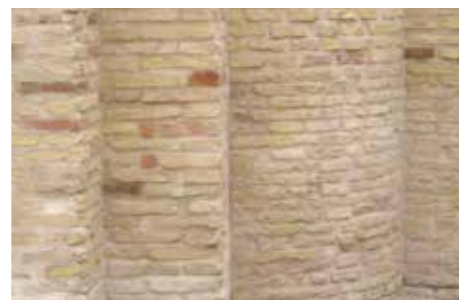
3 Reparación del llagueado realizada sobre muro existente.
