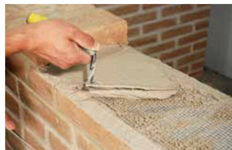
2 Extensión de la segunda capa de GEOCALCE F ANTISISMICO.
