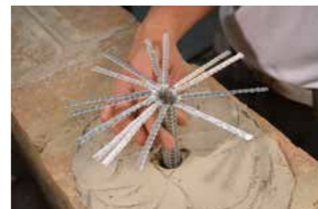
5 Inserción del conector a chicote realizado con tejido GEOSTEEL.
