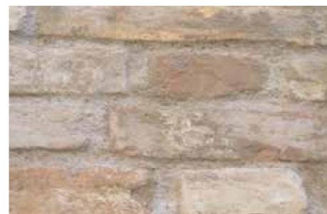
4 Reparación del llagueado con GEOCALCE G ANTISISMICO o GEOCALCE F ANTISISMICO.
