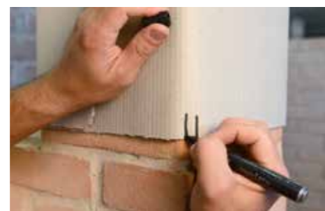
2 Replanteo de las zonas de tejido donde efectuar los doblados.
