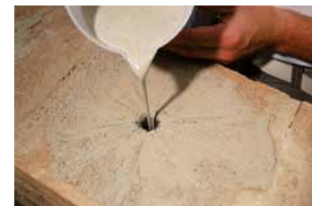
6 Anclaje del conector con GEOCALCE FL ANTISISMICO.
