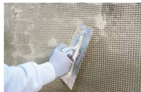
Instalación del tejido biaxial de fibra de basalto GEOSTEEL GRID.
