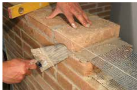
3 Colocación de los elementos de ladrillo.
