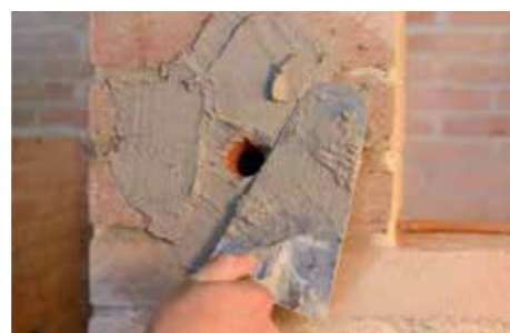
Aplicación de la primera mano de GEOCALCE F ANTISISMICO.
