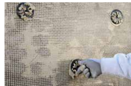
Enroscado de TASELLO STEEL DRYFIX 10.
