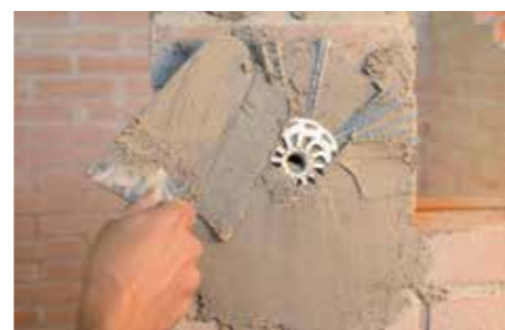
Llagueado final del conector con GEOCALCE F ANTISISMICO.
