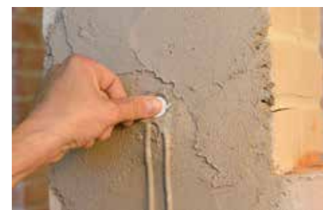
Cierre del agujero de inyección con la correspondiente tapa de cierre.
