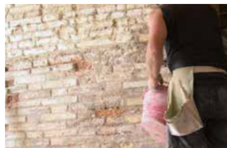
2 Aplicación de GEOCALCE G ANTISISMICO o GEOCALCE F ANTISISMICO.
