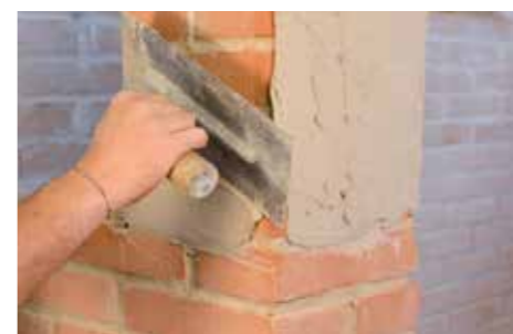
5 Aplicación de la primera mano de GEOCALCE F ANTISISMICO.
