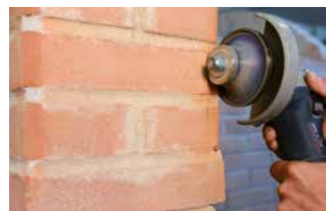
1 Redondeado de las aristas y preparación de las superficies.
