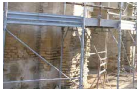
1 Identificación del muro con llagas a perfilar.
