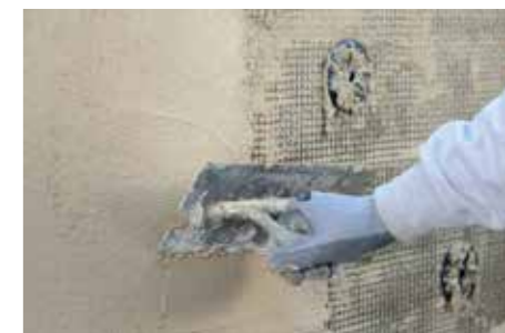
Aplicación de la segunda mano de GEOCALCE F ANTISISMICO.
