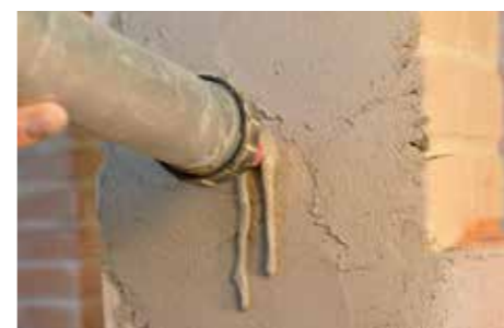
Anclaje del diátono mediante inyección a baja presión de GEOCALCE FL ANTISISMICO.
