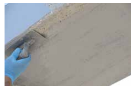
5 Aplicación de la segunda mano de GEOLITE GEL.
