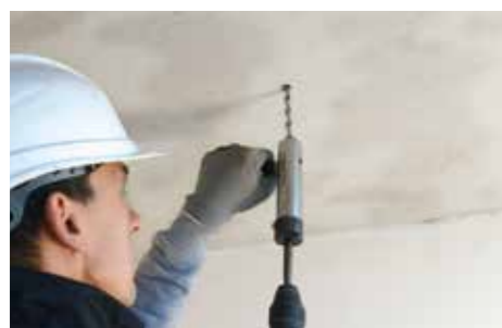
1 Instalación de las barras STEEL DRYFIX.
