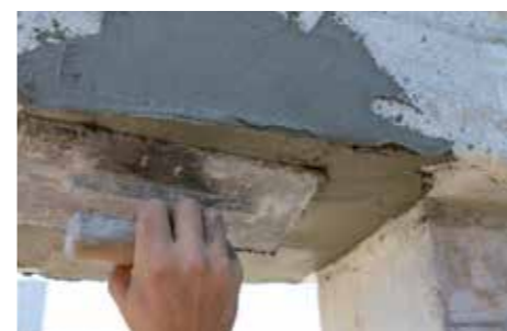
4 Aplicación de primera mano de GEOLITE.
