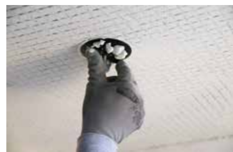
4 Enroscado del TASSELLO STEEL DRYFIX sobre la barra STEEL DRYFIX.
