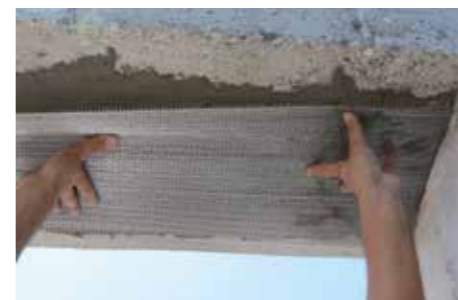
5 Instalación del tejido de fibra de acero GEOSTEEL.
