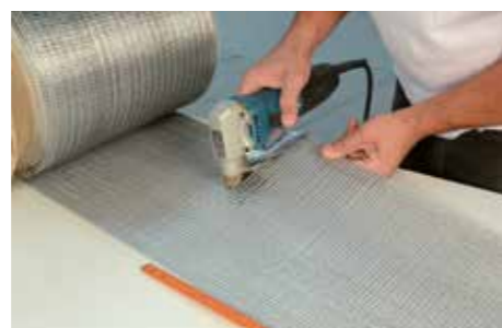
2 Corte del tejido de fibra de acero GEOSTEEL.
