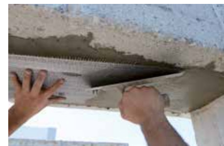
6 Aplicación de la segunda mano de GEOLITE.
