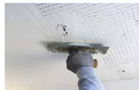
5 Aplicación de la segunda mano de GEOLITE MULTIUSO.
