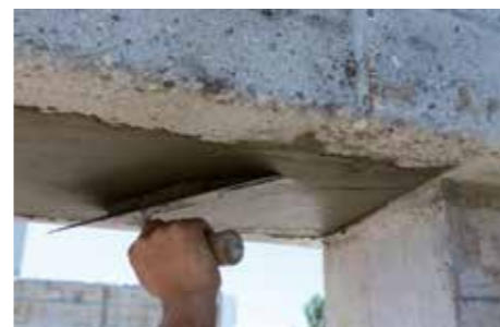
4 Aplicación de primera mano de GEOLITE.
