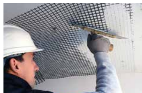
3 Instalación malla GEO GRID 120.
