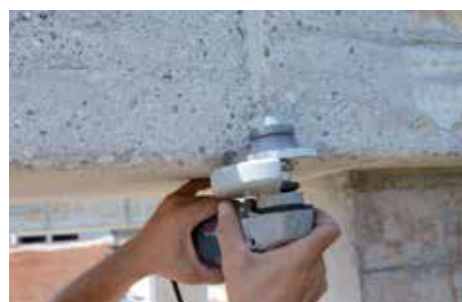
1 Redondeado de las esquinas de las vigas.
