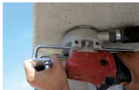
1 Preparación de las superficies de soporte.
