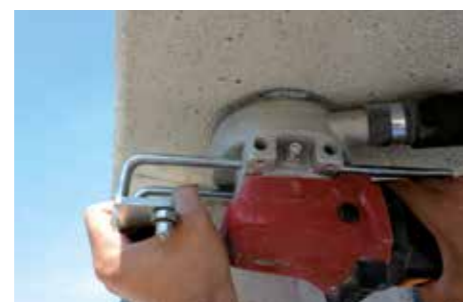
2 Preparación de las superficies de soporte.
