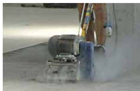
Preparación de los soportes.
