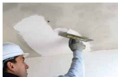
2 Aplicación de la primera mano de GEOCALCE MULTIUSO.
