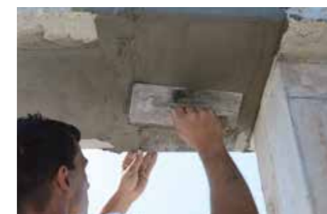
6 Aplicación de la segunda mano de GEOLITE.
