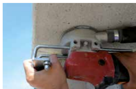
1 Preparación de las superficies de soporte.
