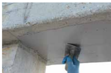
3 Aplicación de la primera mano de GEOLITE GEL.
