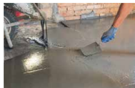
Vertido del SISTEMA GEOLITE FRC.
