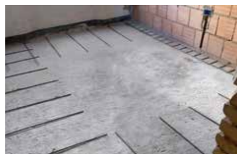
Instalación de la conexión con los muros perimetrales.
