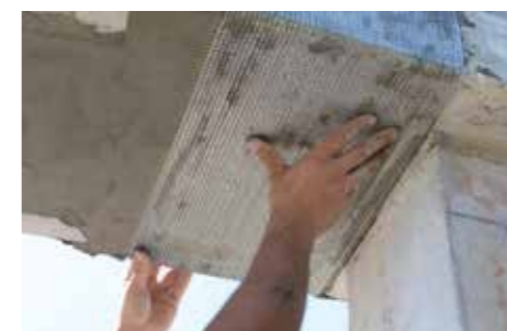
5 Instalación del tejido de fibra de acero GEOSTEEL.
