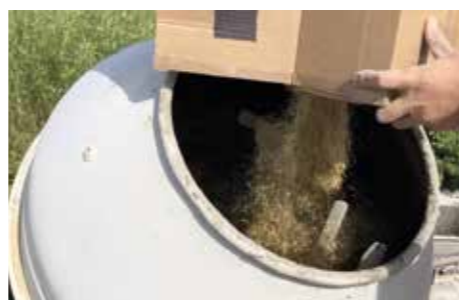
Mezcla del SISTEMA GEOLITE FRC.
