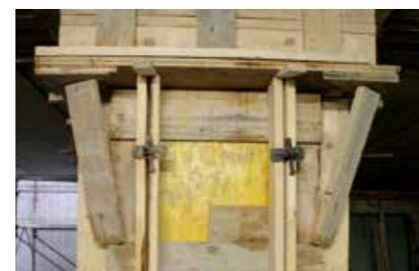
2 Posicionamiento de los encofrados.
