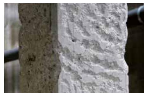
1 Preparación de los soportes.
