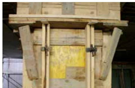
Posicionamiento de los encofrados.
