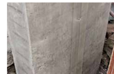
5 Desencofrado de los nuevos vertidos.
