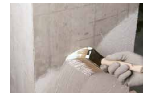
6 Protección con GEOLITE MICROSILICATO.
