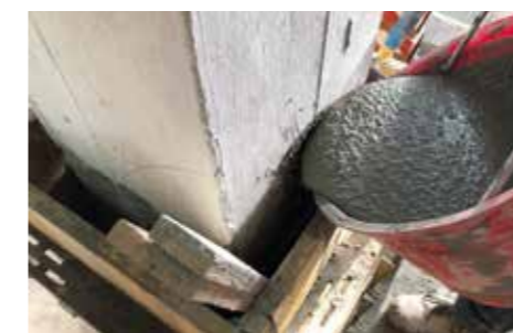
4 Vertido del SISTEMA GEOLITE FRC.
