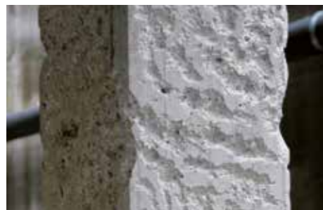
Preparación de los soportes.
