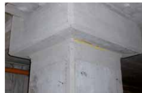
Desencofrado de los nuevos vertidos.
