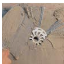
Sellado final del conector tras la inserción de la roseta de polipropileno
