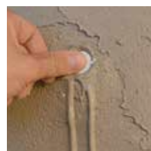
Cierre del orificio de inyección mediante el correspondiente tapón
