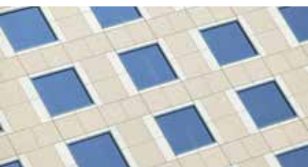
УКЛАДКА КЕРАМИКИ НА ФАСАДАХ
