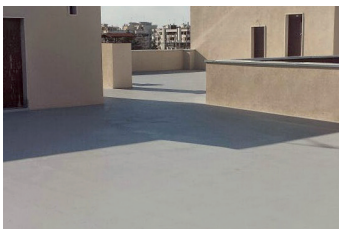
Sistem pohodne dekorativne protidežne hidroizolacije z vlakni
