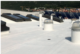
Sistem Cool Roof pe membrane vechi
