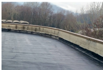
Bitumenski vodonepropusni sustav zaštite od kiše na starim ljepenkama
