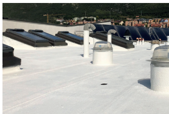
Systeme Cool Roof sur anciennes membranes de toiture
