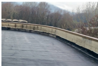
Système d'étanchéité à l'eau bitumineux sur anciennes membranes de toitures
