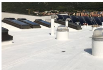
Sistema Cool Roof su vecchie guaine
