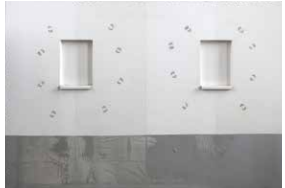
Δοκιμή ελέγχου υδατοστεγανότητας και υδροθερμικής συμπεριφοράς.
