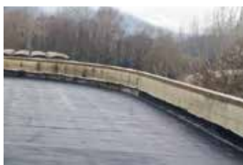
Sistema impermeabilizante bituminoso sobre viejas membranas
