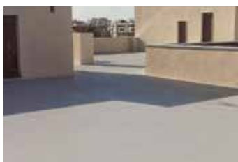
Sistema impermeabilizante decorativo con fibras transitable
