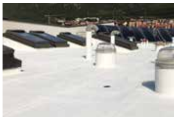
Sistema Cool Roof sobre viejas membranas
