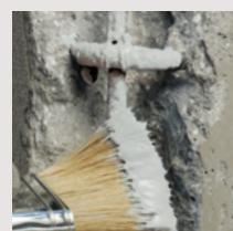
Primena dvokomponentnog antikorozivnog cementnog maltera za zaštitu armaturnih šipki.
