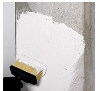
**Geomalta minerale a base di geolegante per il ripristino monolitico del calcestruzzo armato. Colabile multiuso a presa normale 60 min.**
