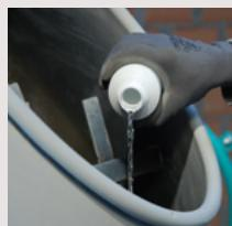
Priprema polimer-modifikovanog maltera sa dodatkom aditiva za sušenje ili usporavanje.
