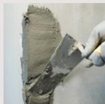
Primena polimer-modifikovanog maltera sa kontrolisanim skupljanjem, ojačanog vlaknima za sanaciju betona.
