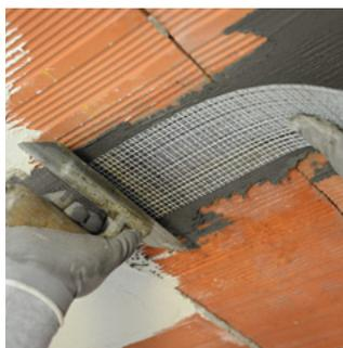
Geolite Magma Xenon in abbinamento con le fibre corte ad alta prestazione Steel Fiber, certificate per uso strutturale, compongono il sistema certificato Geolite FRC per il rinforzo di solai ed elementi in c.a.
