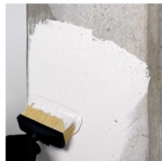
Geomalta minerale a base di geolegante per il ripristino monolitico del calcestruzzo armato. Colabile multiuso a presa normale 60 min.
