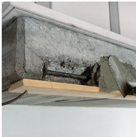
Der Geomörtel, der mit einer einzigen Anwendung:
