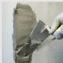
Anwendung von faserverstärktem, polymermodifiziertem Mörtel zur Betonsanierung mit kontrolliertem Schwund.
