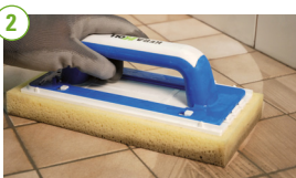
2 Rengör med en stor svamp-platta efter att fogmassan börjat binda.
