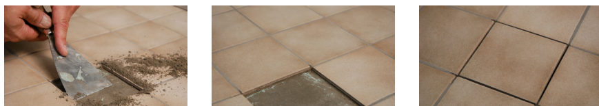
Bild 1 - 3 Ersättning av trasig platta.
