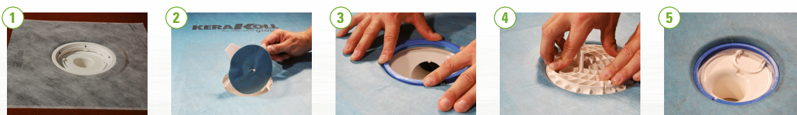
Bild 1 - 5: den preparerade manschetten formas ner i klämringssätet / Skär ut hål i manschetten med vass kniv / Applicera klämringen / Tryck fast klämringen i sätet / Vattentätning klar med KERADRAIN brunnsmanschett och NANODEFENSE® ECO.
