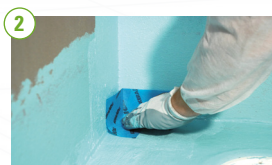
KERACORNER lamineras med NANODEFENSE® ECO.
