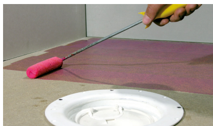
Behandling med KERAGRIP ECO
