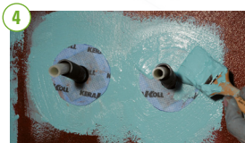
KERAPIPE- manchett monterad - förseglas med NANODEFENSE® ECO.
