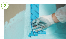
KERABLOCK TEX 100 lamineras med NANODEFENSE® ECO. I Våtzon 2 kan fiberduksremsan KERATAPE användas.
