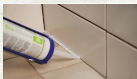
FUGABELLA® ECO SILICONE appliceras som rörelsefog.
