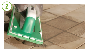
2 Applicera fogmassa med en hård gummispackel.
