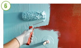
NANODEFENSE® ECO stryks på i 2 omgångar med en tjock roller. Åtgång: min 1,5 kg/m 2 totalt.
