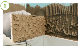
Kontrollera täckningsgraden.
