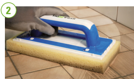
Rengör med en stor svamp-platta efter att fogmassan börjat binda.
