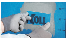
Tryck fast en lapp med minst 2 cm överlapp runtom.
