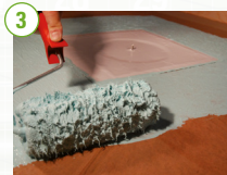
3 NANODEFENSE® ECO stryks runt golvbrunnsmanschetten.
