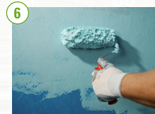
6 Ett tunt lager NANODEFENSE® ECO (0,2 kg/m 2 ) stryks ovanpå folieduken.
