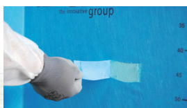
Skär bort den skadade folieduken.
