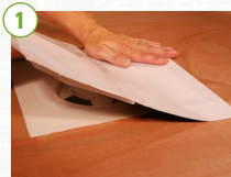
1 KERADRAIN KLISTERKANT dubbelhäftande manschett monteras över golvbrunn och primerbehandlat golv.
