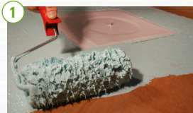
NANODEFENSE® ECO appliceras med tjock roller.
