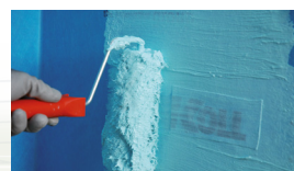
Stryk NANODEFENSE® ECO för att återförsegla ytan.
