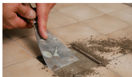
Bild 1 - 3 Ersättning av trasig platta.
