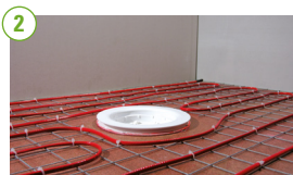
KERATECH® ECO HP4 självutjämnande avjämningsmassa eller KERALEVEL® ECO LR byggspackelmasa skall användas för fastgjutning av värmekabel och stål nät på golv. Notera att kabel fästs vid stål nätet med buntband.
