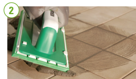
Applicera fogmassa med en hård gummispackel.
