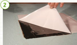
Skyddspappret tas bort på manschetten.
