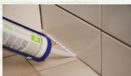
FUGABELLA® ECO SILICONE appliceras som rörelsefog.
