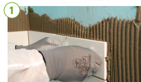
Pressa plattan mot underlaget vid montering.
