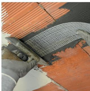
Geolite Magma Xenon in abbinamento con le fibre corte ad alta prestazione Steel Fiber, certificate per uso strutturale, compongono il sistema certificato C.V.T. Geolite FRC per il rinforzo di solai ed elementi in c.a..
