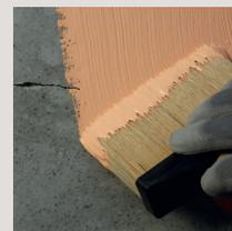
Applicazione di pittura elastomerica protettiva antifessurazione.
