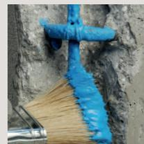
Applicazione di malta cementizia anticorrosiva bicomponente per la protezione dei ferri d'armatura.
