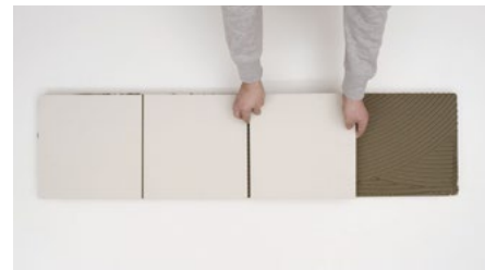
Pose des carreaux
