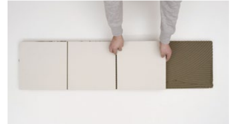
Verlegen der Fliesen
