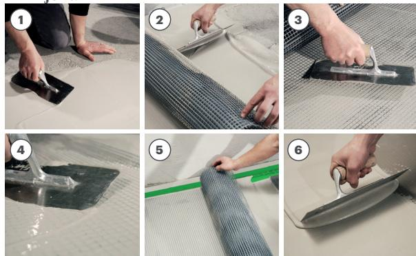
① Primijeniti Aquastop Nanoflex glatkim gleterom debljine sloja 1-2 mm utiskivajući kako bi se dobila maksimalna adhezija za podlogu. Debljina sloja ovisi o površinskoj dovršenosti i ravnini podloge.
