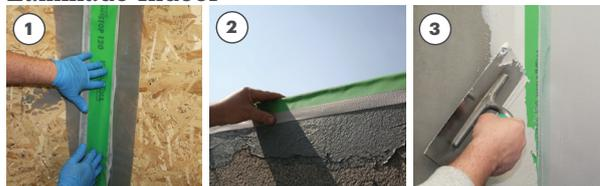
Seguir el procedimiento anteriormente ilustrado para el encolado de la banda Aquastop 120 con impermeabilizantes Aquastop:
