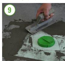
U slučaju kada se lijepljenje vrši hibridnim gel-ljepljim Biogel® Extreme izbjegavajte nanošenje u najtopljam satim; ako se stvore mješavini ili nabori uslijed isparavanja otapala koji je sadržan u gel-ljeplju, zagladite membranu lopaticom nakon 10-20 minuta od nanošenja.
