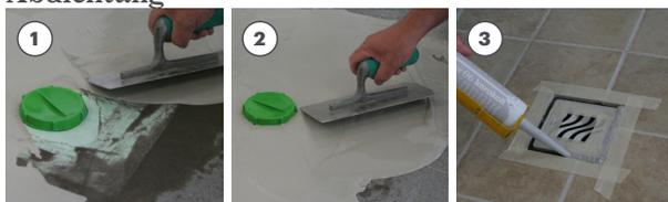
Beim Abdichten der Flächen die Membran mit zwei Schichten Dichtstoff überdecken (wenn eine Armierung mit Aquastop AR1-Netz vorgesehen ist, den Rand der Membran um mindestens 10 cm überlappen); dabei die Bildung von Gegengefällen durch zu hohe Schichtstärken vermeiden. Vor der Belagsverlegung den Gitteraufsatz auf die Schichtstärke des verlegten Materials zuschneiden. Den grünen Verschluss erst direkt vor dem Einsetzen des Gitteraufsatzes entfernen.
