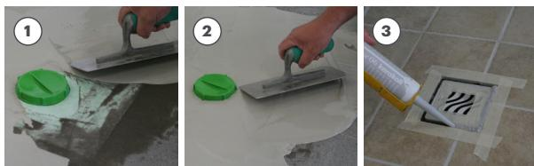
Prilikom hidroizolacije površina membranu pokriti sa dva sloja hidroizolacije (tamo gdje je potrebno armiranje mrežicom Aquastop AR1, preklopite membranu najmanje 10 cm); izbjegavajte stvaranje kontra nagiba uzrokovanih prevelikim debljinama. Prije nego što nastavite
